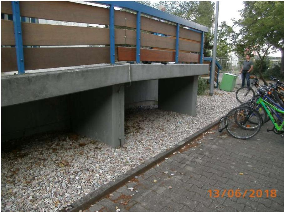
Bild 5 + 6: Vorhandene Rampe, Zugang zum Haupteingang; entspricht nicht der DIN 18040 Teil1
