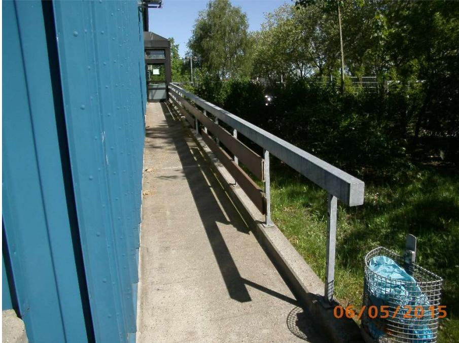
Bild 7: Rampe zur Liegewiese; entspricht nicht der DIN 18040 Teil1
