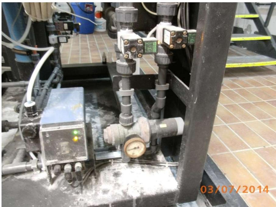
Bild 1: Nach der Havarie des Zellenblocks. Geschädigte Technik durch ausgetretenes Natriumhypochlorid.
