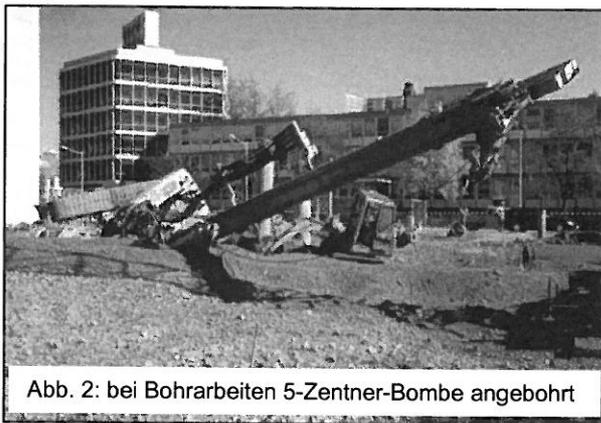
Abb. 2: bei Bohrarbeiten 5-Zentner-Bombe angebohrt
