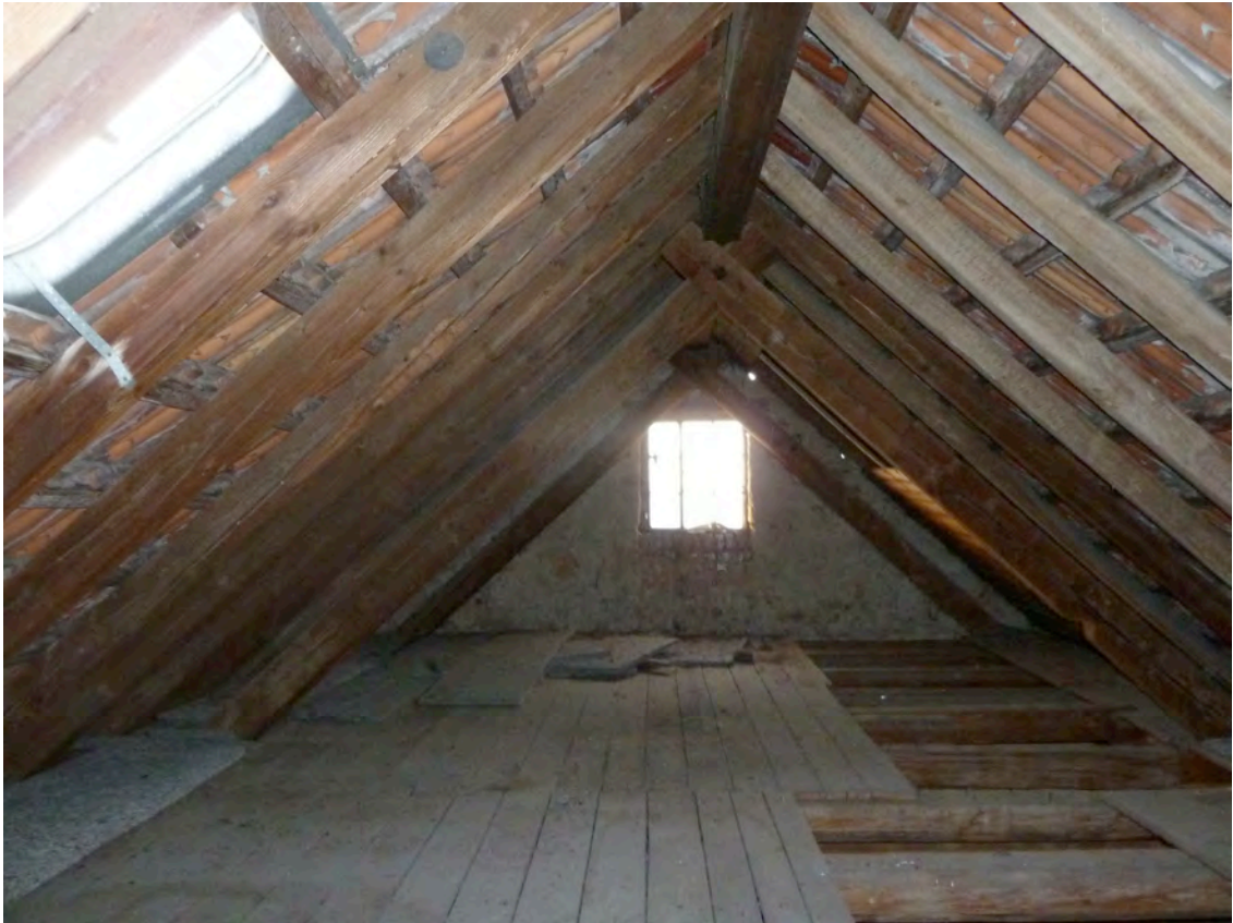
Abb. 7: Mühlengebäude, Dachgeschoss (Spitzboden)
